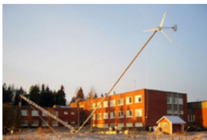
Innovatiivisen teräsrakennesuunnittelun ansiosta Tuule 200 koneiston paino on vain 140 kg, mikä mahdollistaa tuulivoimala -asennuksen ilman nostinautoa.
