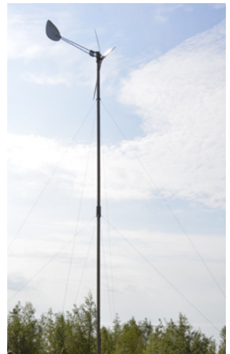
Parhaan tuloksen saamiseksi potkurin korkeudelta katsottuna maaston tulee olla avointa joka suuntaan. Korkea 18 metrin masto parantaa energian tuottoa.
