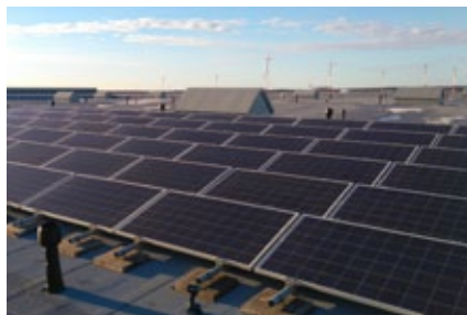
Tasakatolle aurinkopaneelit voidaan asentaa painotussuilla, joiden pinta-ala 10% tai jopa 20% paneelin pinta-alasta.
