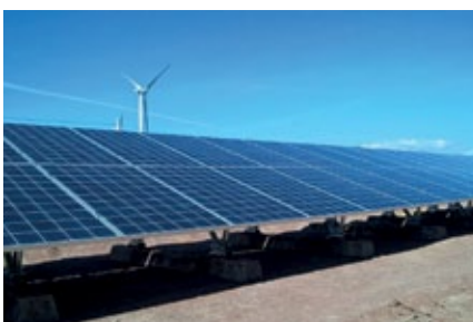
Maa-asennusjärjestelmä valitaan maaperän mukaan. Vaihtoehtoina mm. ruuvipaalu, teräsjuuri, painollinen asennusjärjestelmä.
